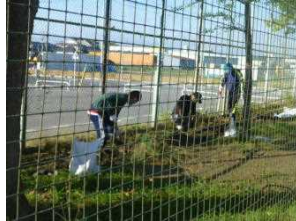
側溝の泥上げ作業
